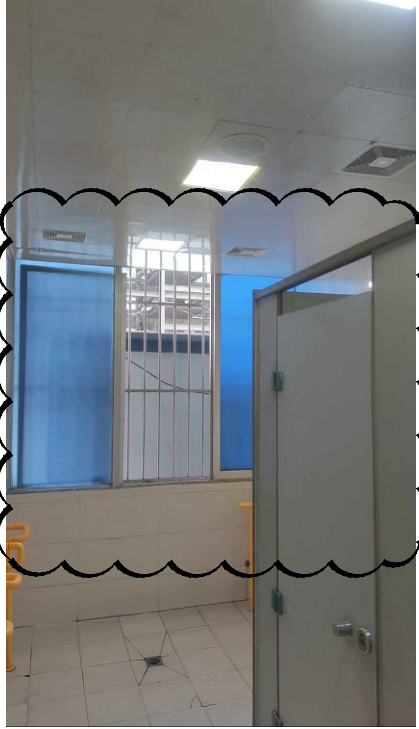
综合楼一层公共卫生间男卫女卫各增加两台低噪音，20w窗排气扇 电源由原吊顶电源迁入
