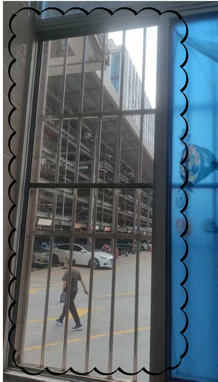
综合楼急诊科一层更衣室纱窗更换, 尺寸1600*1900mm（以现场实际尺寸为准）， 中医治疗室增加2400*2100mm铝合金纱门（以现场实际尺寸为准）
