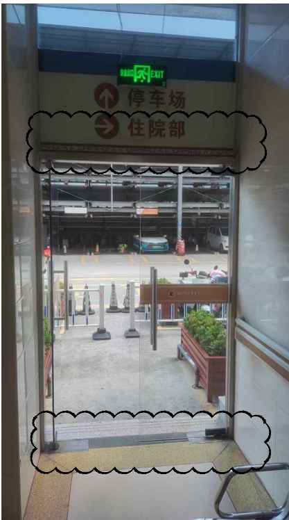
综合楼门诊放射科玻璃门更换上下门夹
