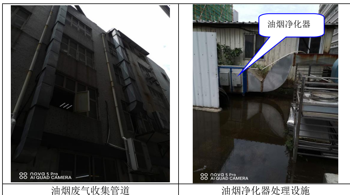
图 5.2-1 废气处理设施实际建设情况
