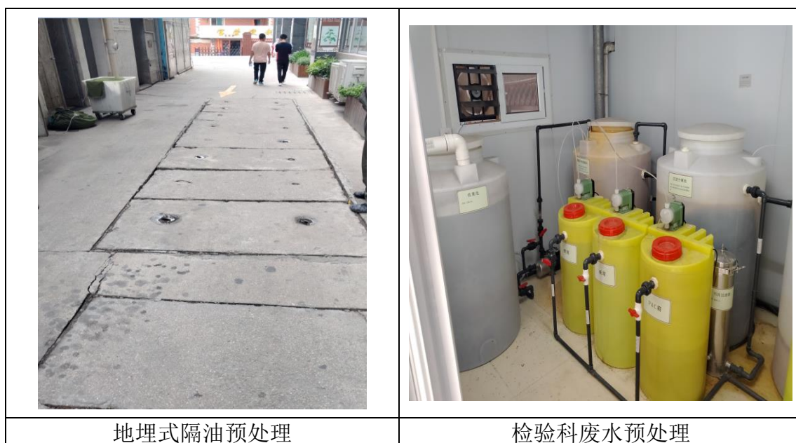
图 5.1-3 废水处理站实际建设情况
